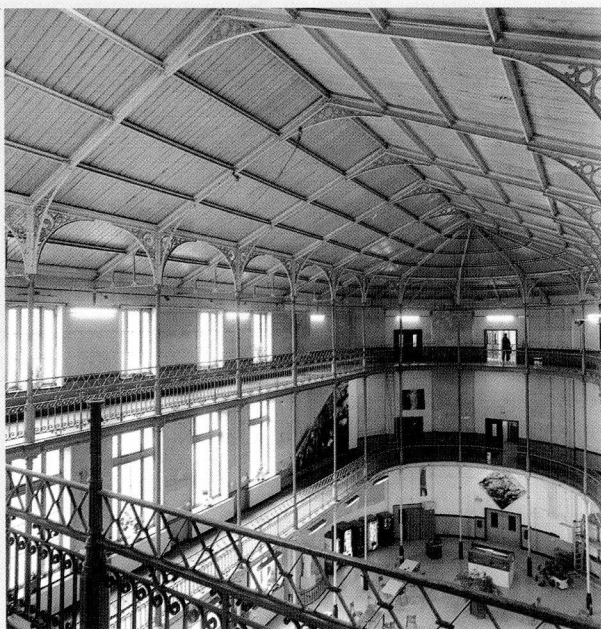
Achter de bescheiden gevel van het voormalig atheneum schuilt dit spectaculair metalen gebinte.
