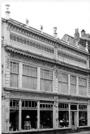
Gevel van de voormalige porseleinfabriek Demeuldre-Coché, opgetrokken in 1905 door architect Maurice Bisschops.
